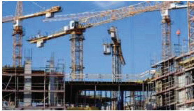
Görsel 3.34: Kaldırma aracı-kule vinç
