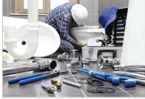
Görsel 3.44: Sıhhi tesisatta çalışma
